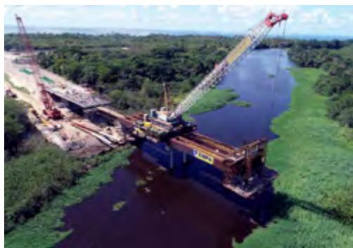
A plataforma de armazenamento do cantitraveller neste projeto foi executada por um estrado de 14 m de largura por 13,5 m de comprimento, sobre o qual estavam uma grua e os martelos vibratórios e de percussão para cravação de estacas, além de outros materiais de apoio. O movimento longitudinal no cantitraveller é realizado por cilindros hidráulicos e dispõe de travão mecânico. O guia de cravação de estacas tem sua movimentação também feita por cilindros hidráulicos.
