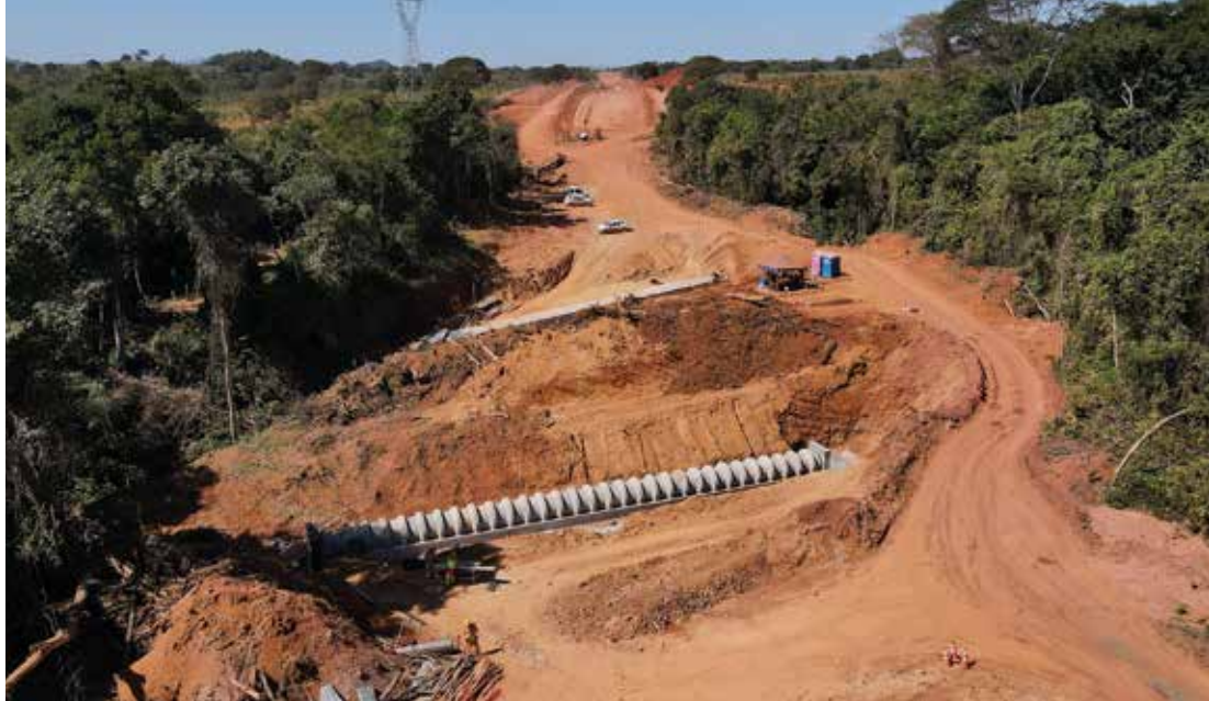
Trabalho de infraestrutura no km 7
