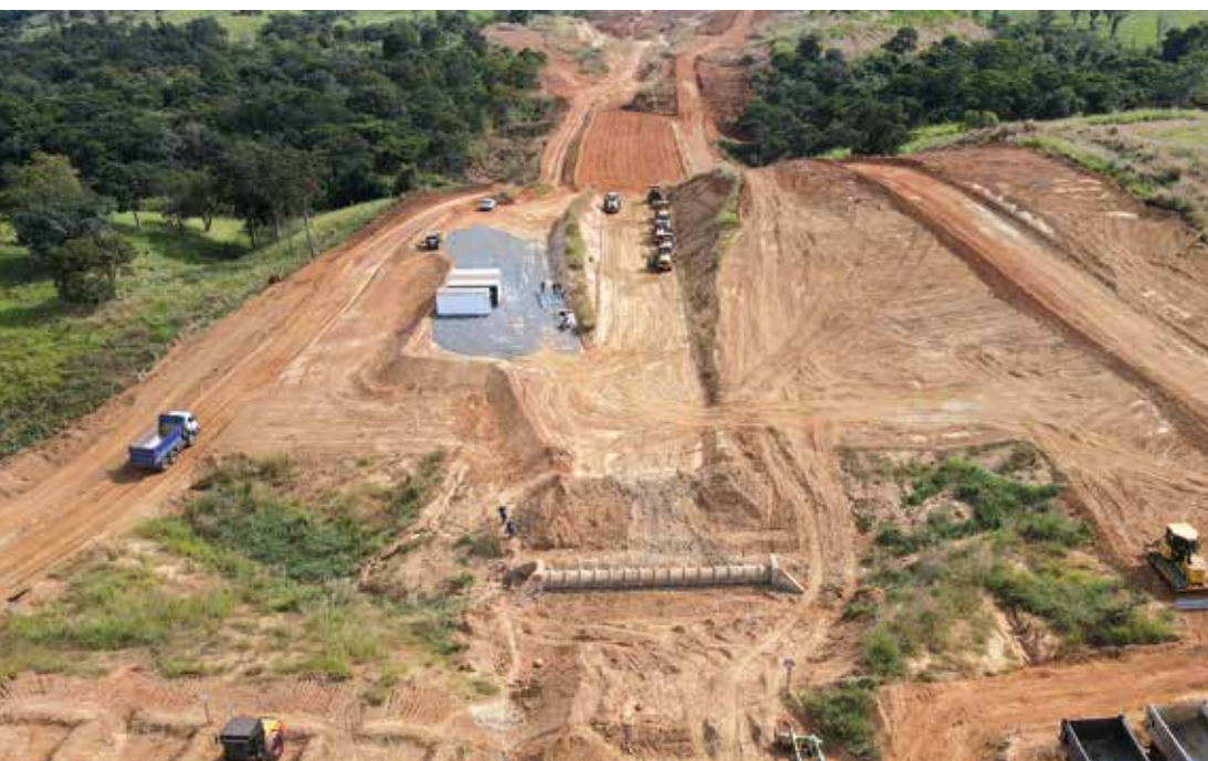
Obra da Fico atingiu 50 mil metros cúbicos de aterro compacto por dia
