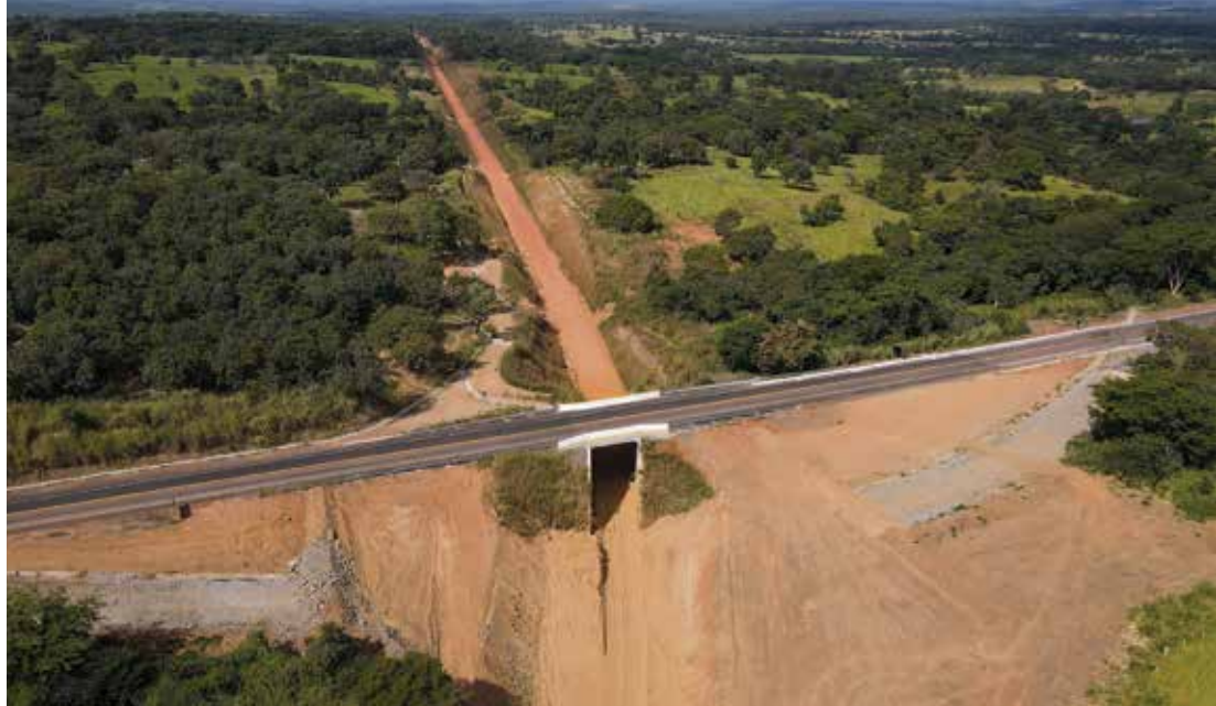
A infraestrutura dando caminho para a chegada da superestrutura na Fico
