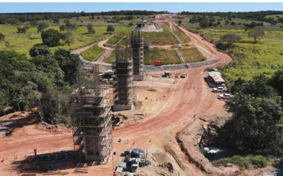
Pilares para uma das pontes da ferrovia
