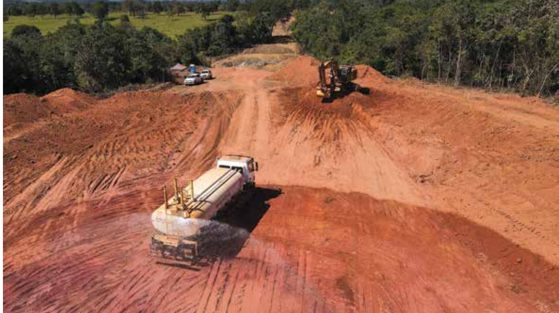
Construtoras trabalham na infraestrutura em cinco lotes
